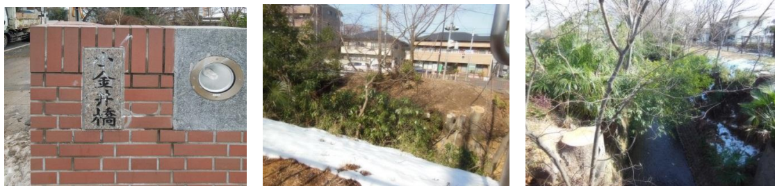
小金井橋の橋名板(左岸東側)
