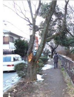
大枝が折れた No.869①
