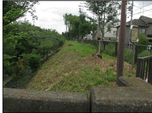
新小金井橋下流右岸
