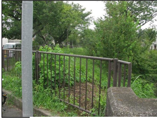
新小金井橋下流左岸
