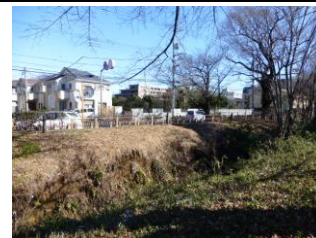
左岸の柵内、対岸より写す
