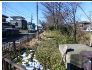
右岸の柵内（蕎屋橋）
