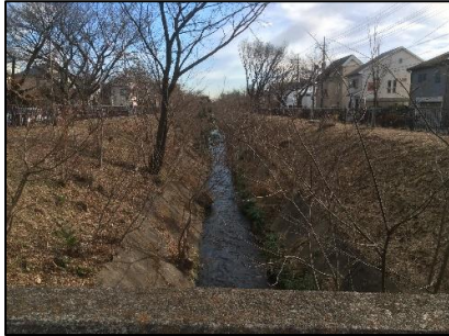
新小金井橋下流
