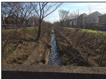
新小金井橋下流
