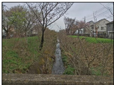
新小金井橋下流
