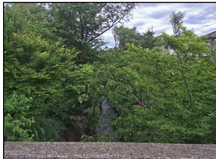
新小金井橋下流
