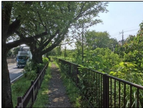
332、N18 付近 下草繁茂
