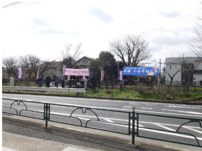
平右衛門橋全景
