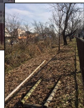
支柱撤去作業
