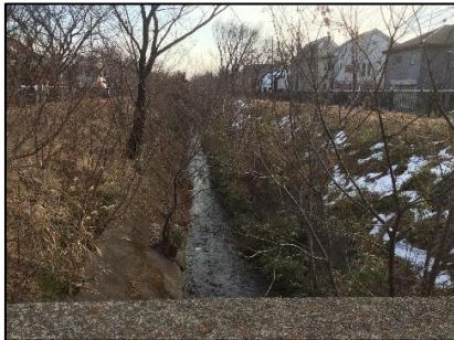
新小金井橋下流
