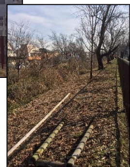
支柱撤去作業
