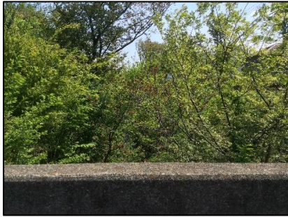
新小金井橋下流
