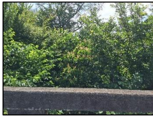
新小金井橋下流
