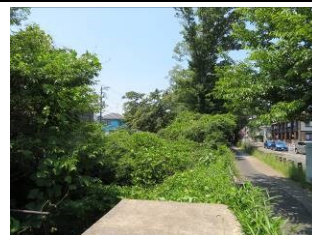
茜屋橋上流側の水路
