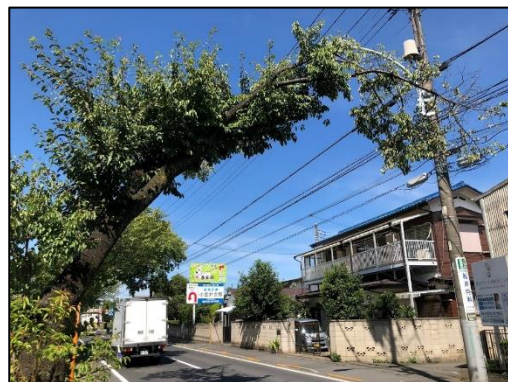
折れた大枝が垂れ下り危険(＃434、左岸)
