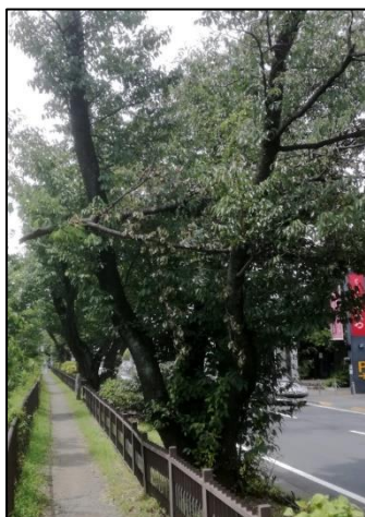
折れた大枝が引っ掛かり 危険(＃421、左岸)
