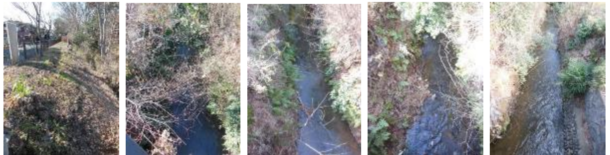
小金井橋西側土手
