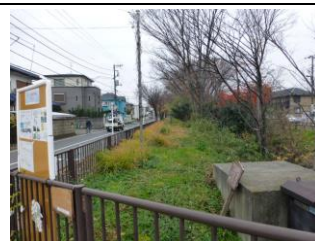
右岸の柵内（茜屋橋）
