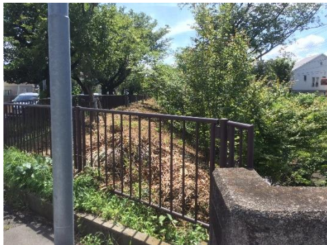
新小金井橋下流左岸
