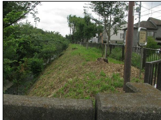
新小金井橋下流右岸
