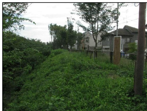
新小金井橋下流右岸
