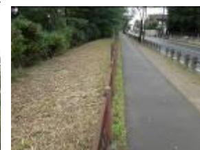
小金井橋北側
