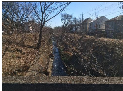
新小金井橋下流
