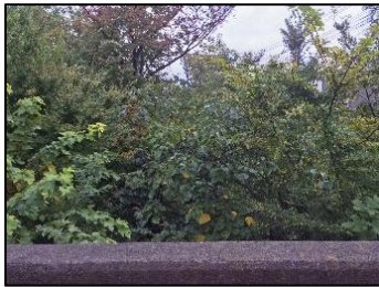
新小金井橋下流
