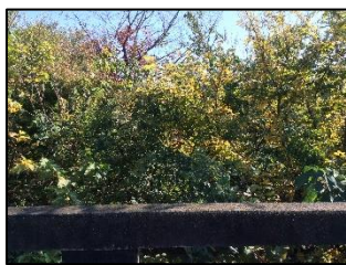
新小金井橋下流
