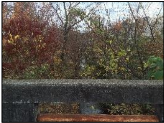
新小金井橋下流
