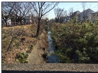
新小金井橋下流
