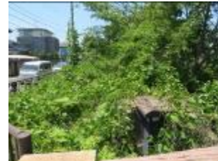
茜屋橋上流側の柵内
