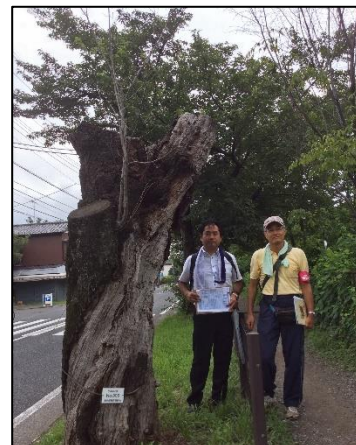
調査風景；第3ブロック
